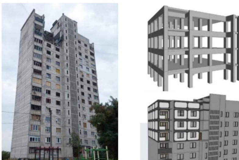
Рис. 3. Загальний вигляд пошкодженої будівлі, шлях від результатів пошкодження до повного відновлення будівлі за допомогою сучасних методів відновлення (розроблено А.В. Колчановим)
