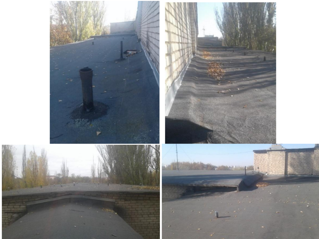
Рис. 2. Фото даху будівлі I корпусу ХНТУ
