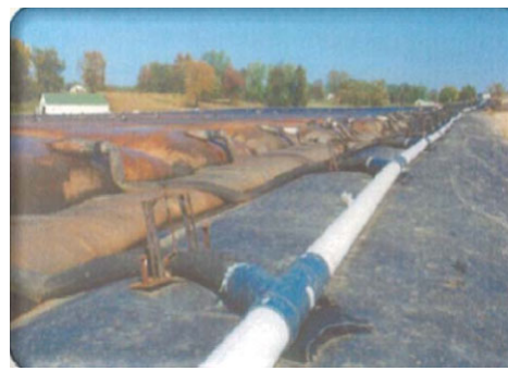
Рис. 8. Вбудована система змішування суспензії із зворотною трубою (1) та пристрій розвідної системи напірних труб (2)
