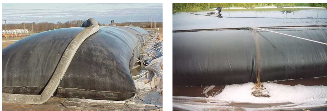
Рис. 5. Етапи наповнення – зневоднення за технологією Geotube
