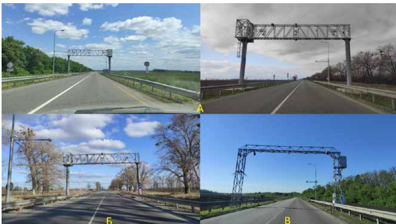
Рис. 9. Пункт габаритно-вагового контролю. А – м. Суми; Б – с. Овлаші, Роменський район; В – с. Юсківці, Миргородський район
