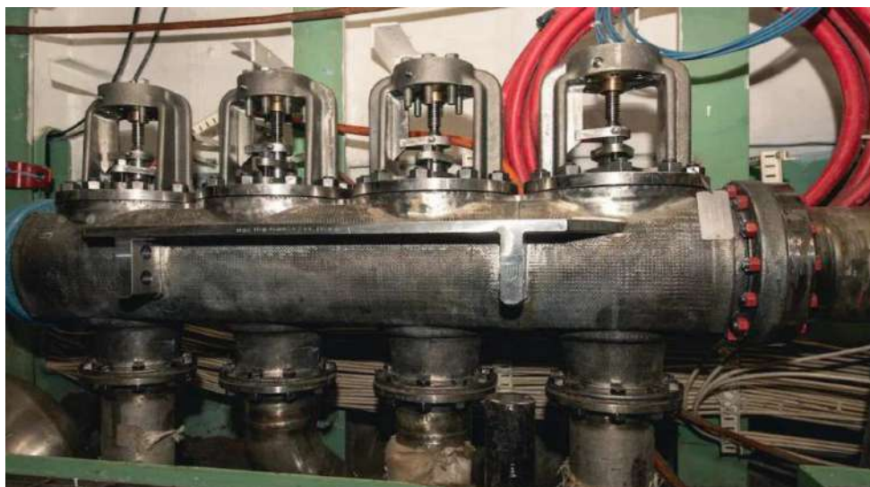
Рис. 2. Клапаний колектор американського авіаносця
